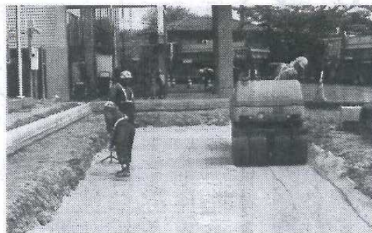
一層目にリサイクル造粒砂を施工
